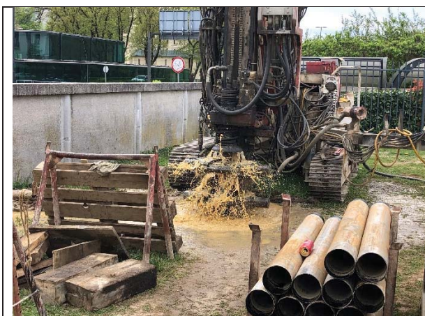
Slika 10: Izvedba airlifta na vrtini RVIL-1/20 takoj po začetku aktiviranja
