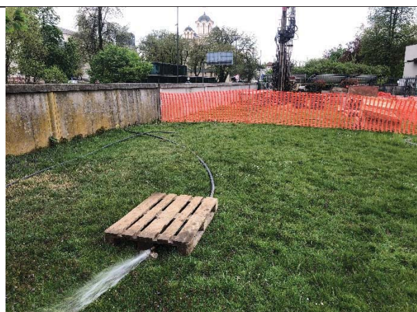
Slika 11: Izvedba airlifta na vrtini RVIL-1/20 po 8 urah čiščenja
