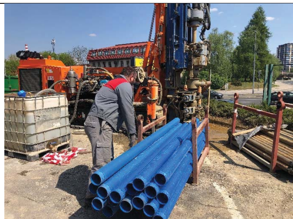
Slika 9: Cevitev vrtine RVIL-2/20
