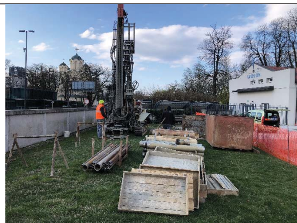
Slika 6: Vrtanje vrtine RVIL-1/20
