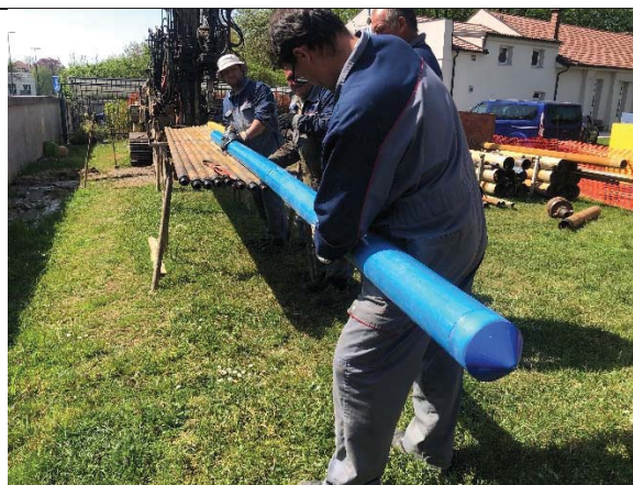
Slika 7: Cevitev vrtine RVIL-1/20
