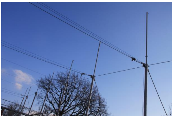
Sliki 2.2 in 2.3.: Pogled na nosilno konstrukcijo platnene strehe, na katero se bodo po ojačitvi montirali platneni roloji. Prvi pogled je s strani Avditorija Križanke, drugi pa s strani Zoisove ceste.
