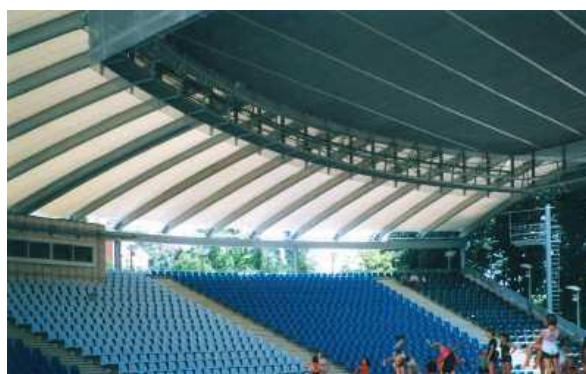
Sliki 1.3 in 1.4.: Primer pomične platnene strehe v odpirajočem se in zaprtem položaju.
