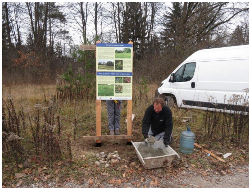
Slika 17: Postavljanje tabel, 20. 11. 2015, in izdelava betonskih temeljev.
