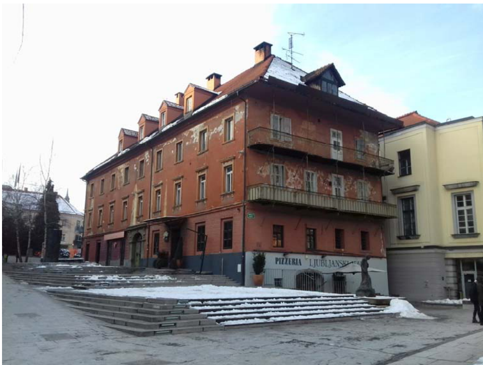
VZHODNA IN JUŽNA FASADA STAVBE DVORNI TRG 1, KONGRESNI TRG 11
