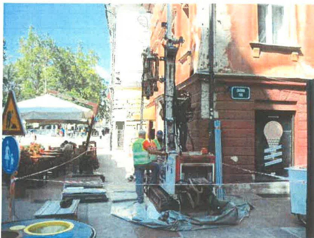
Slika 2: Prikaz preiskovanega območja – zahodni del objekta, vrtina V-1 (03.08.2017)
