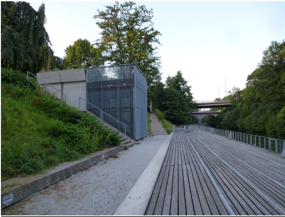
Pogled na servisni objekt v smeri proti severu
