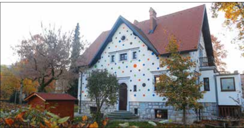
Vrtec Mladi rod, enota Čira čara, se ponaša z novimi okni in vrati, razsvetljavo ter fasado, prav tako sta novi streha in razdelilna kuhinja.
