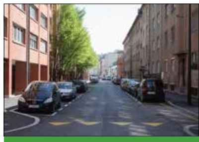
Na Kotnikovi ulici je Mestna občina Ljubljana obnovila vodovod, kanalizacijo in vročevod, Elektro Ljubljana pa je obnovil svojo infrastrukturo. Javna razsvetljava je namesto na fasadah urejena na drogovi.
