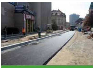
Dela na Gosposvetski ulici potekajo skladno z načrti, meščani ste se izkazali z razumevanjem in potrpežljivostjo glede zagat v prometu, ki jih je prinesel s seboj ta zahteven gradbeni projekt.
