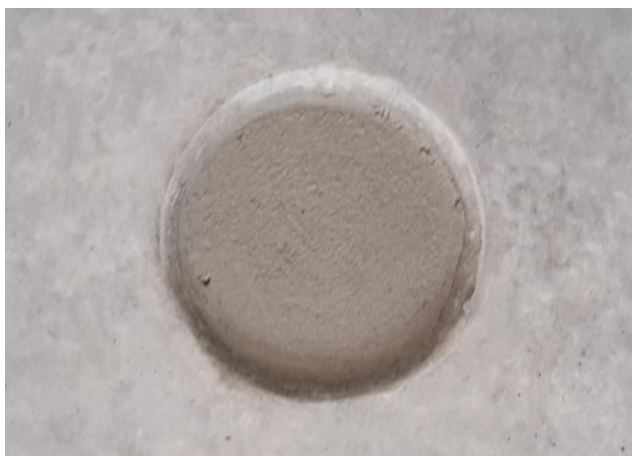
Slika 9: Prikaz zapolnjevanja odprtih opažnih povezav.
