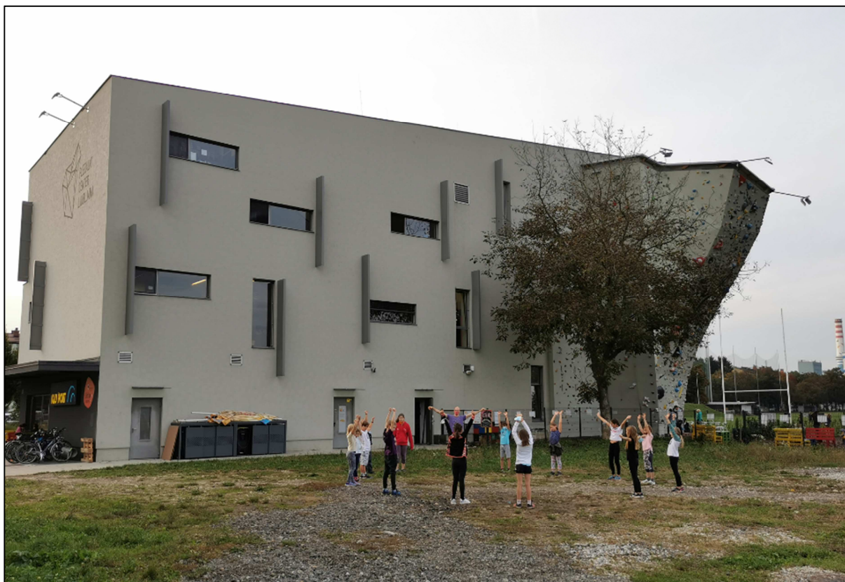
Slika 18: Pogled na Plezalni center z južno-vzhodne strani
