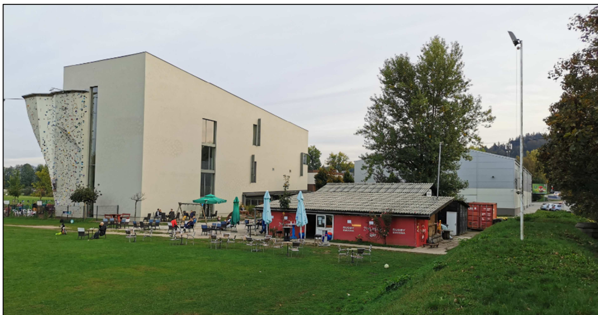
Slika 20: Pogled na Plezalni center s severo zahodne strani, kjer je predvidena prizidava (lokacija LP med Plezalnim centrom in objektom Ragby Olimpija)
