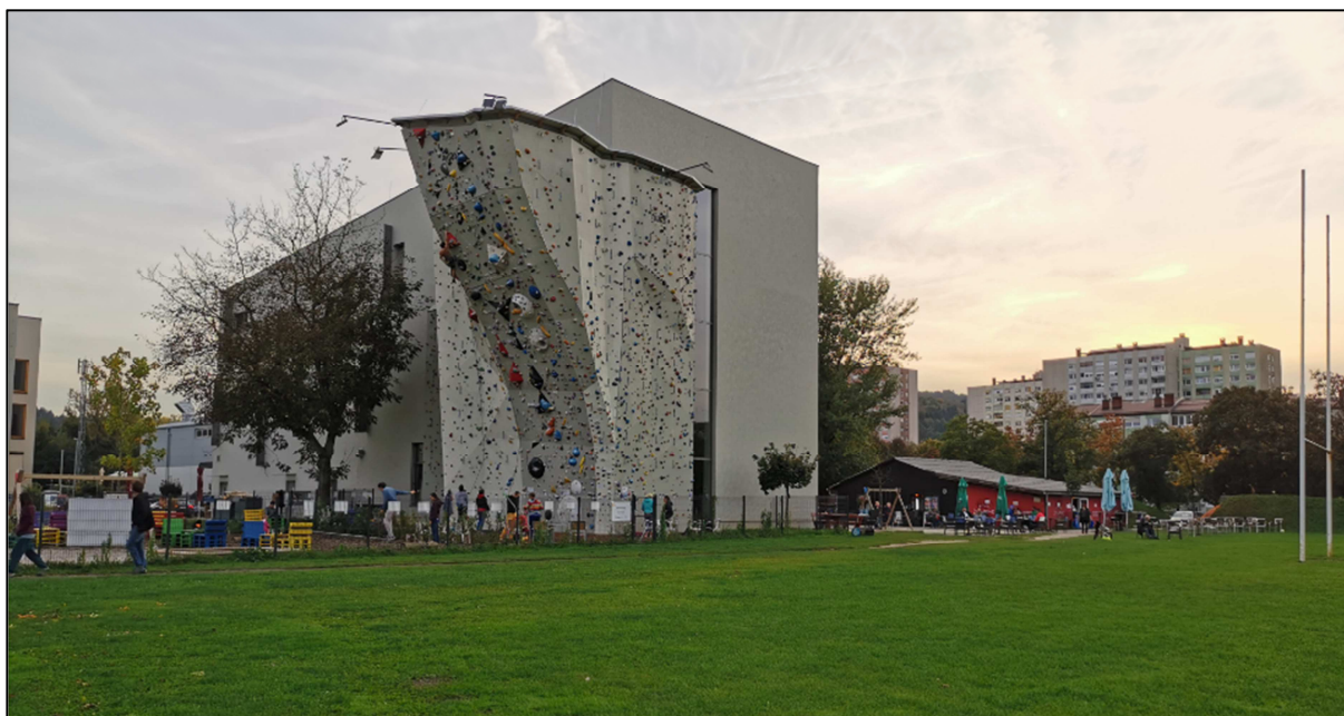
Slika 19: Pogled na Plezalni center s severo-vzhodne strani
