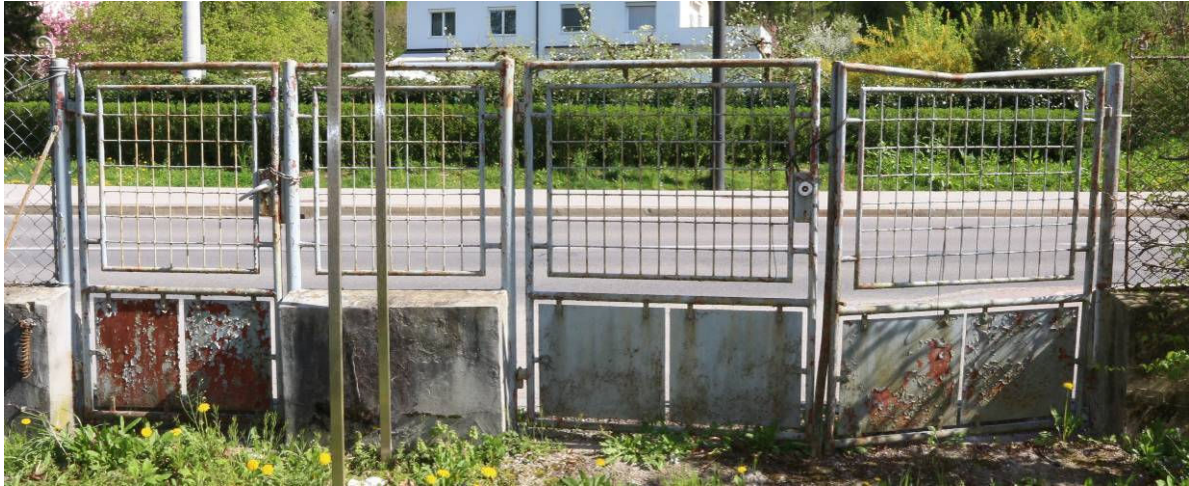
Novejši del ulične ograje. Od leve proti desni: enokrilna vrata za pešce + ograja + dvokrilna vrata za avto
