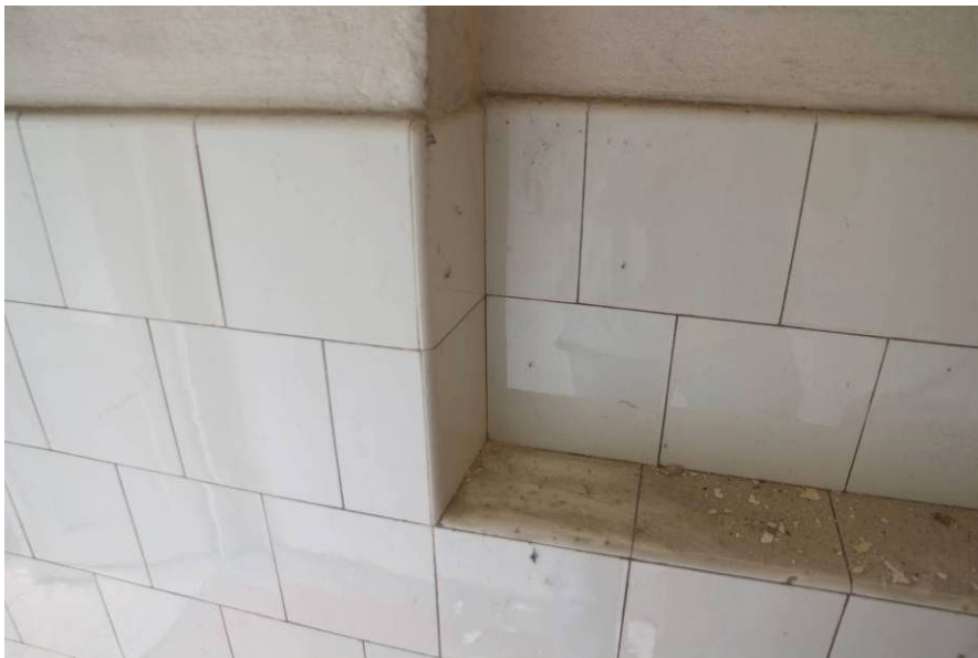
Stenske keramične ploščice, bele, dimenzij 15 x 15 cm.
