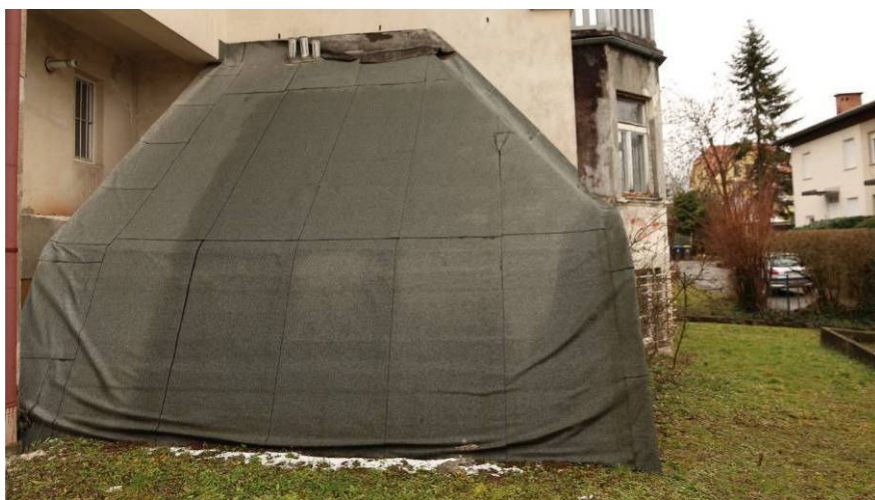
Zaklonišče, oblečeno v hidroizolacijo, položeno na toplotno izolacijo.
