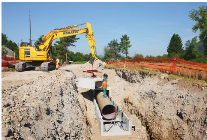
Gradnja kanala C0, vidna sta cev in kineta ( vir )
