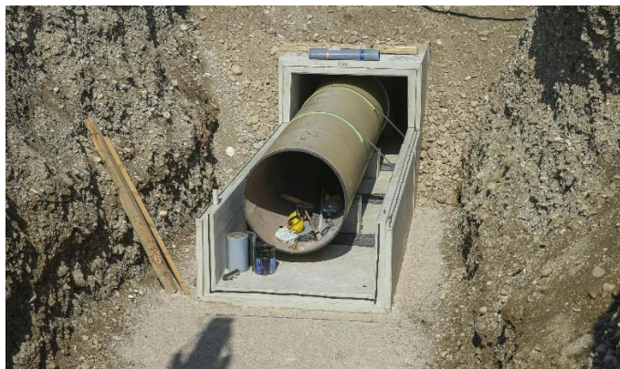
Gradnja kanala C0, vidna sta cev in kineta ( vir )
