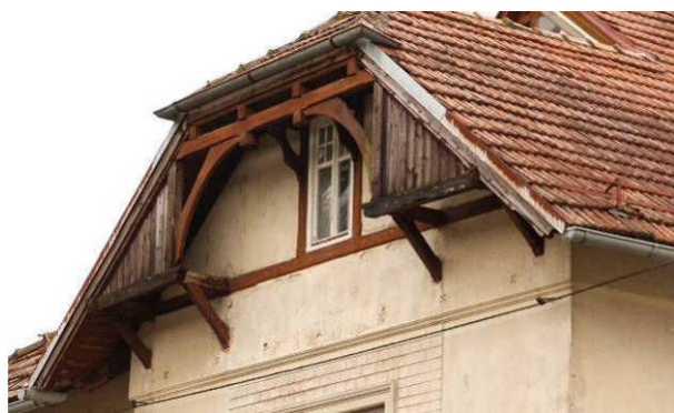
Viden opaž in konstrukcijski les na S (levo) in V fasadi (desno).
