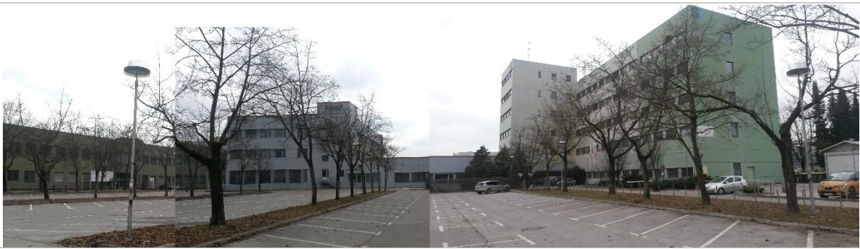
Pogled na obravnavano lokacijo
