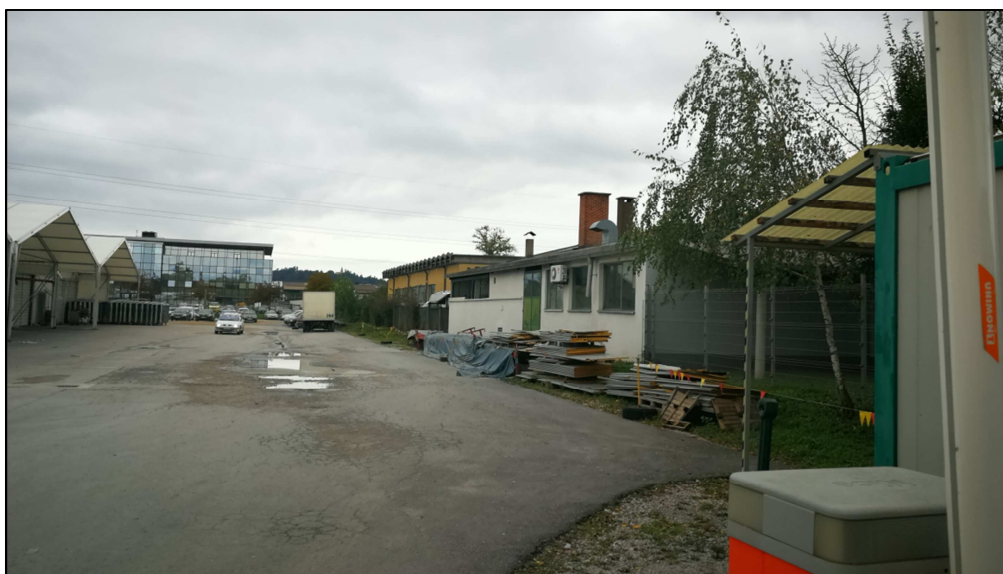
Slika 9: Območje LP na vzhodu meji na obstoječe skladiščne objekte - neurejeno, degradirano območje
