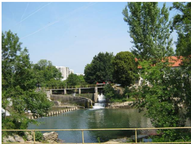
Slika 16: Pogled na fužinski jez z desnega brega
