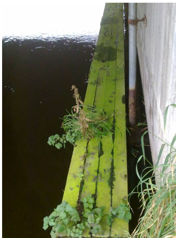
Slika 34: Lesena plavajoča (pontonska) polica pod mostom, ki je na Danskem v uporabi že dve desetletji, je funkcionalna in ne potrebuje skoraj nobenega vzdrževanja.
