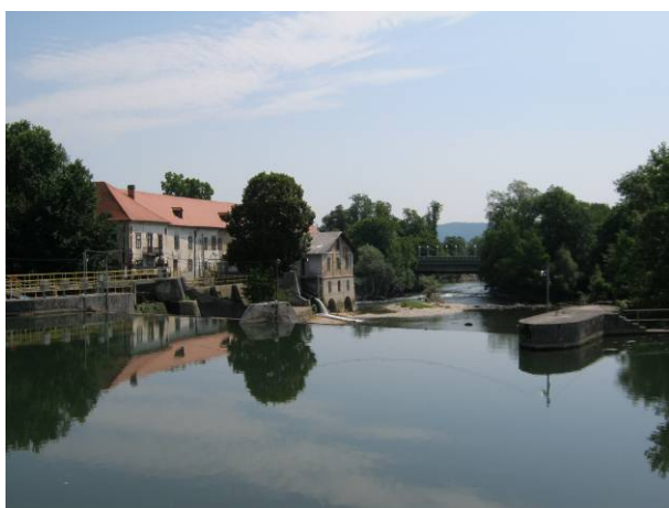
Slika 14: Fužinski grad stoji na levem bregu Ljubljanice. Na sliki je pogled na fužinski jez od zgoraj.
