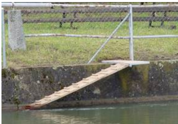
Slika 29: Lesene rampe, ki se prilagajajo nivoju vode, so enostavna in uspešna rešitev za prehajanje vidre in bobra prek ovir.
