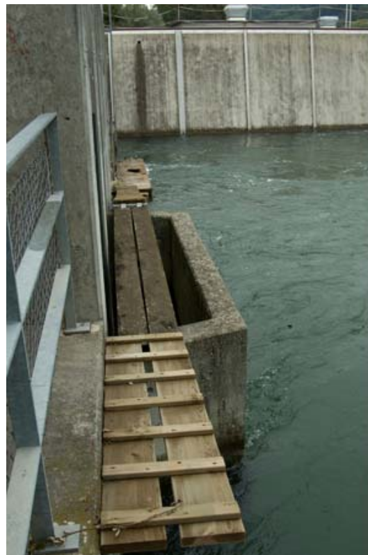
Slika 32: Rešitve za prehajanje vidre in bobra čez ovire tehnično niso niti zahtevne niti drage.
