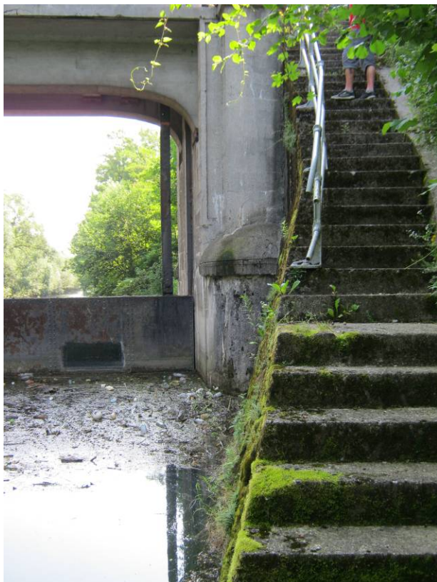
Slika 5: Betonske stopnice nad zapornico na desnem bregu
