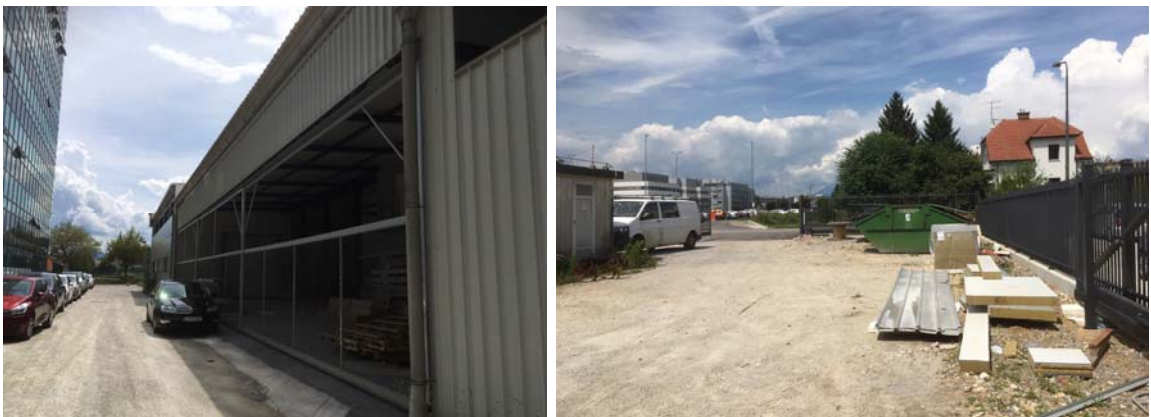
Slika 8: Pogled s na vzhodno fasado skladiščnega objekta in dvorišče na severni strani, vir: LUZ d.d.
