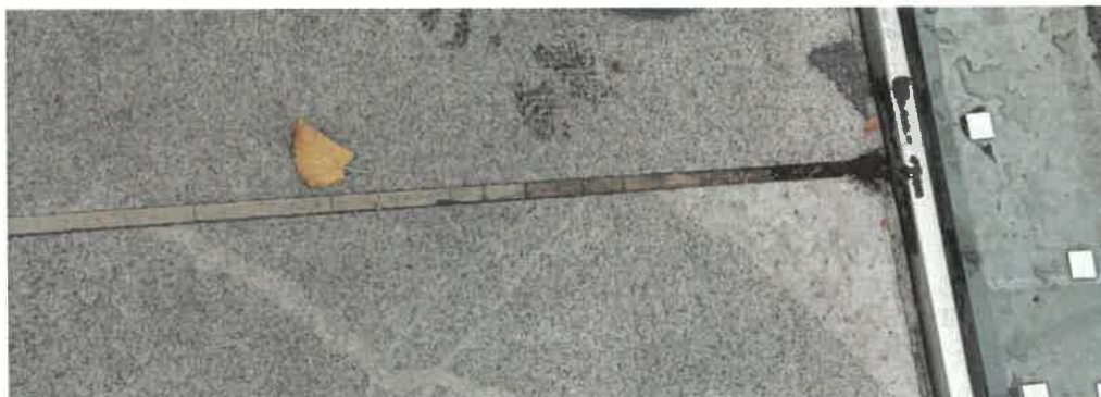
Slika 2-1 Poškodovane – razpokane fugirne mase med tonalitnimi ploščami na osrednjem pohodnem delu objekta.
