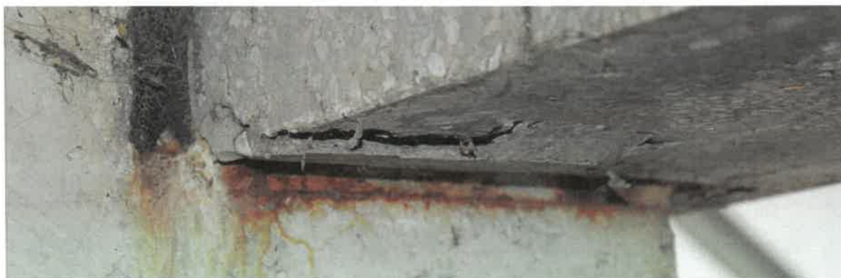
Slika 2-4 Korodirane jeklene plošče v stopniščih STOP1 in STOP2. Na sliki je vidna tudi poškodba (luščenje) betona na korodiranem mestu.
