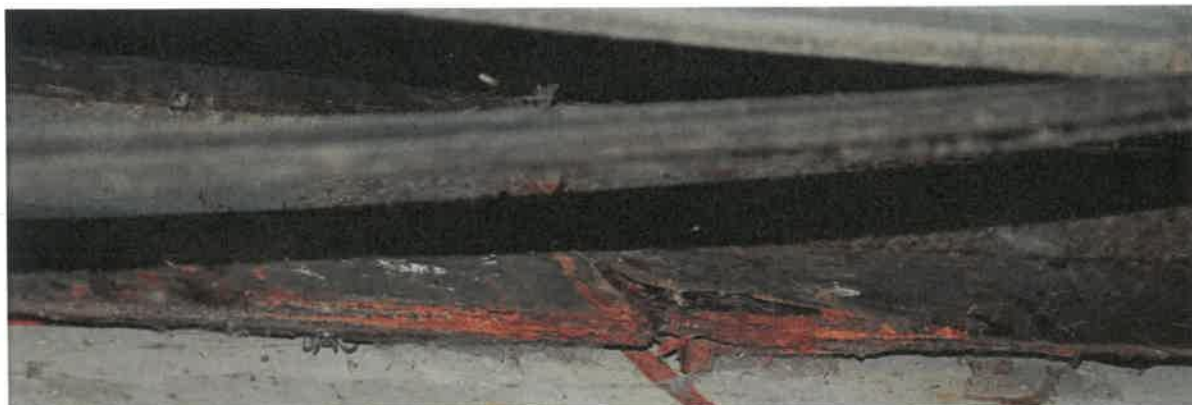
Slika 2-3 Korodirani jekleni deli konstrukcije – prikazana je pločevina dilatacije DIL1.
