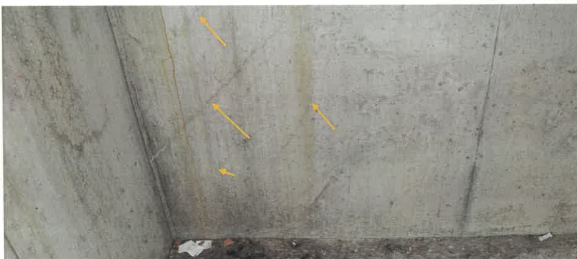
Slika 2-6 Diagonalne razpoke v stebrih levobrežnega podpornika PO1.
