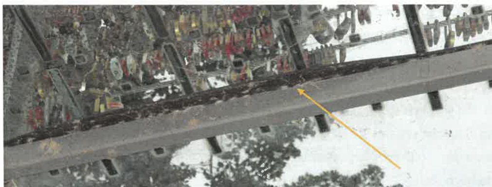
Slika 2-5 Iztiskanje gumene podloge pod stekleno ploščo.
