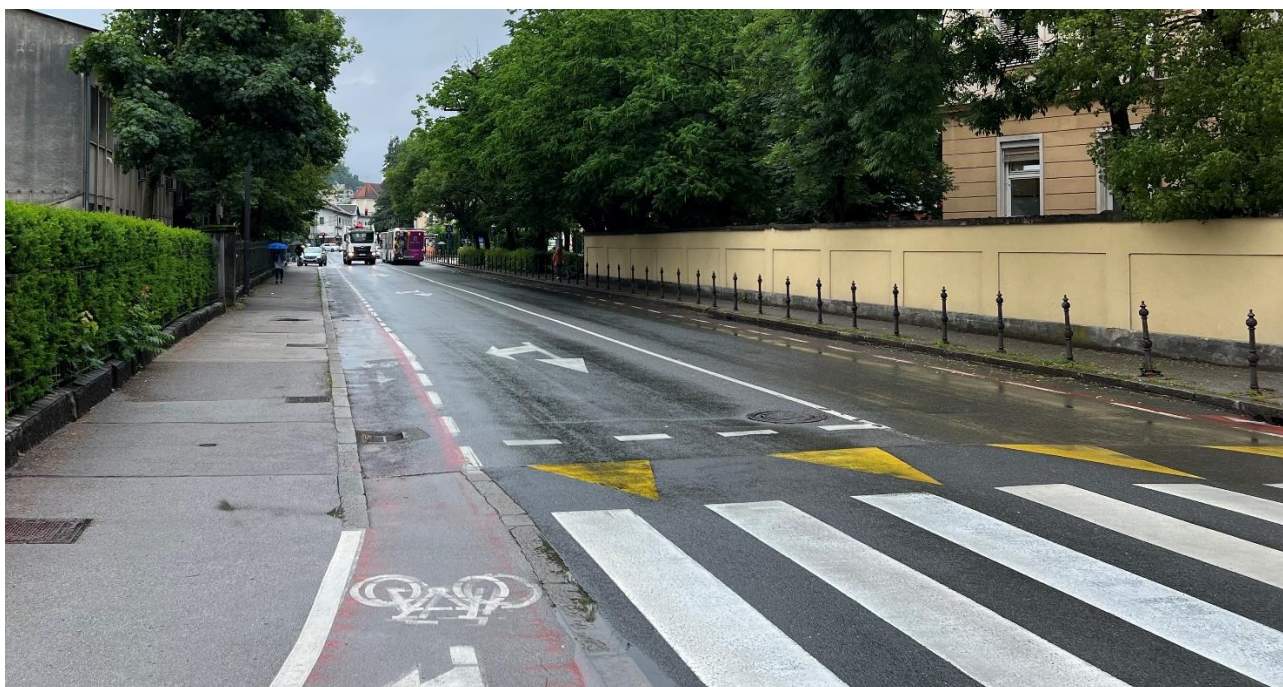
Slika 11: Nivojsko dvignjeni prehod za pešce na križišču Zaloške ceste in Očetovske ulice (vir: Savaprojekt, foto: Janžovnik, 2023).
