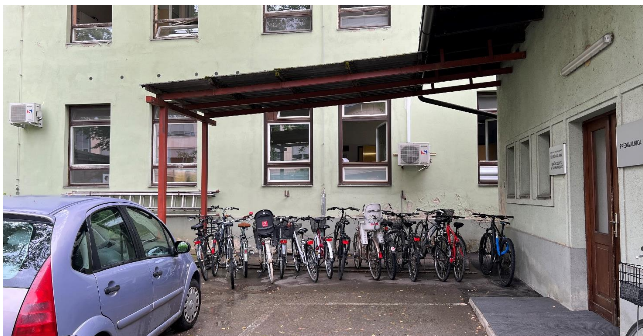
Slika 10: Pokrita kolesarnica pri Travmatološki kliniki (vir: Savaprojekt, foto: Janžovnik, 2023).
