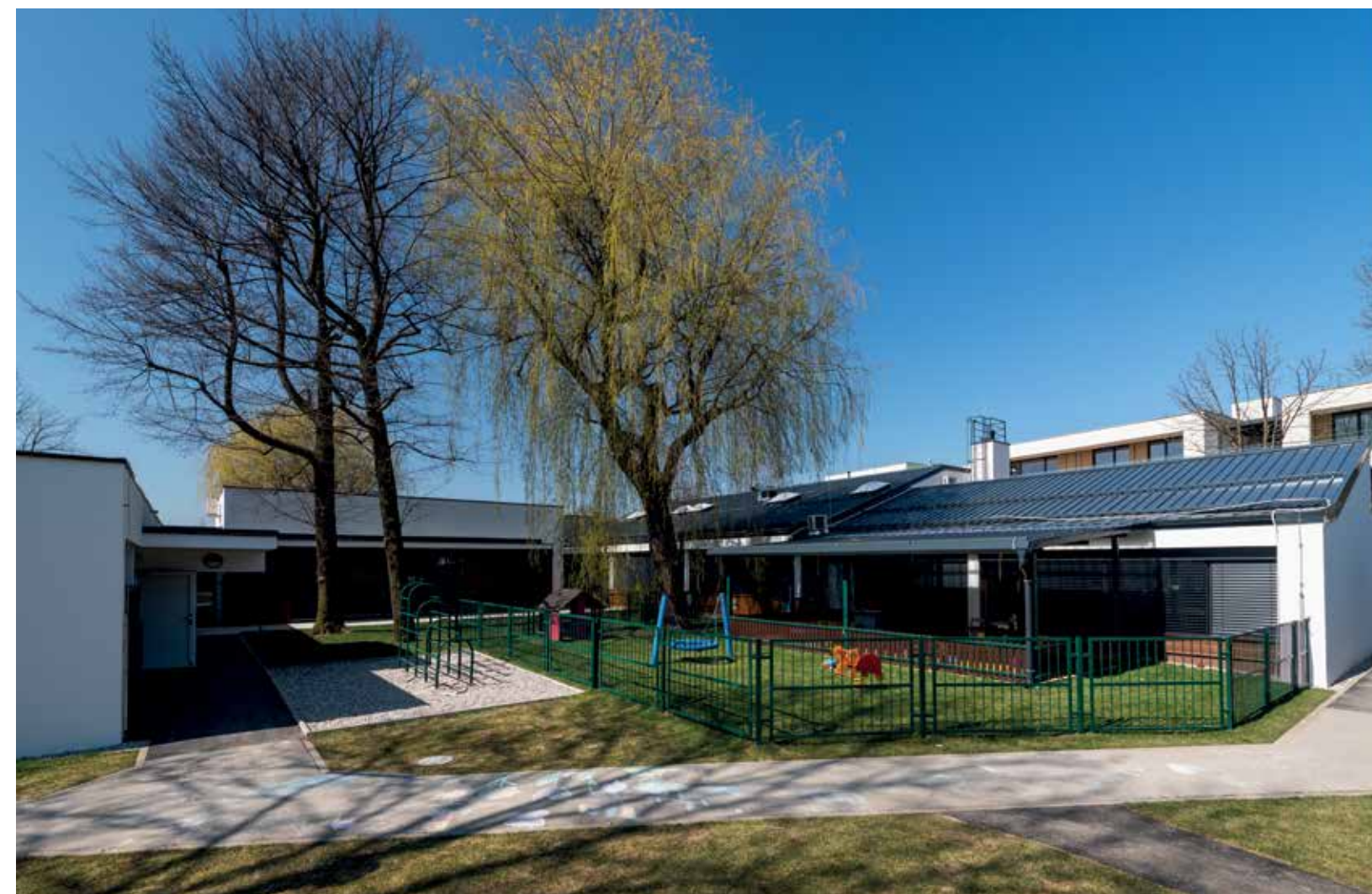
Celovito obnovljen vrtec Kolesija, enota Murgle
