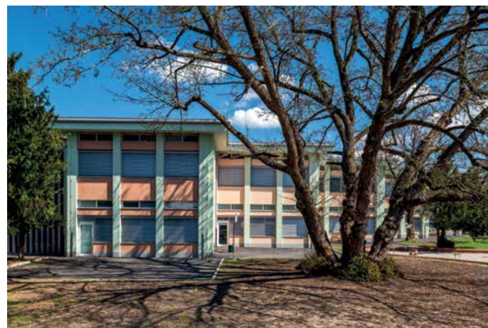
Poleg energetske prenove so se na OŠ Poljane razveselili prenovljene šolske avle.
