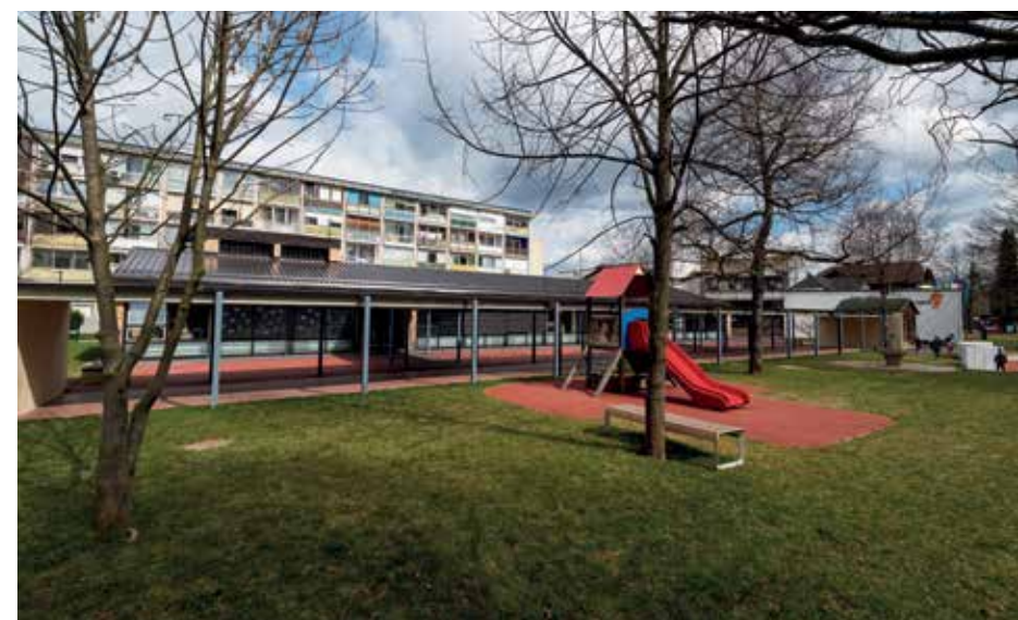
Celovito obnovljen vrtec Miškolin, enota Rjava cesta
