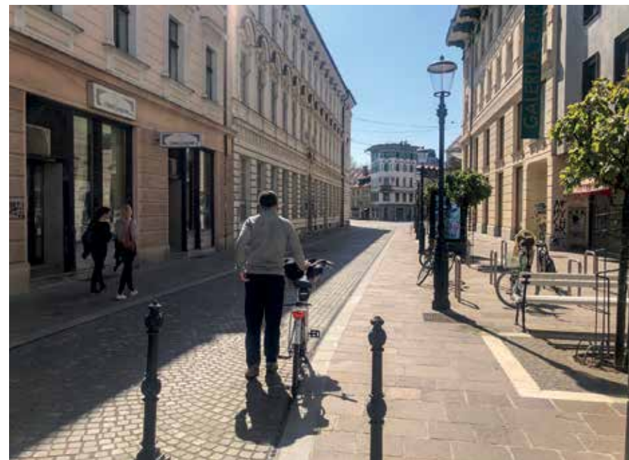
Celovita prenova Trubarjeve ulice je poleg nove podobe vključevala tudi obnovo in gradnjo kanalizacije, vodovoda, plinovoda, vročevoda, optične infrastrukture ter javne razsvetljave. V okviru prenove smo prenovili tudi priključne ulice, in sicer Obrežno stezo, ulico Za čreslom ter Prečno, Kastelčevo, Znamenjsko, Usnjarsko ter Vidovdansko ulico. Projekt sta delno sofinancirala Evropska unija iz Kohezijskega sklada in Republika Slovenija.
