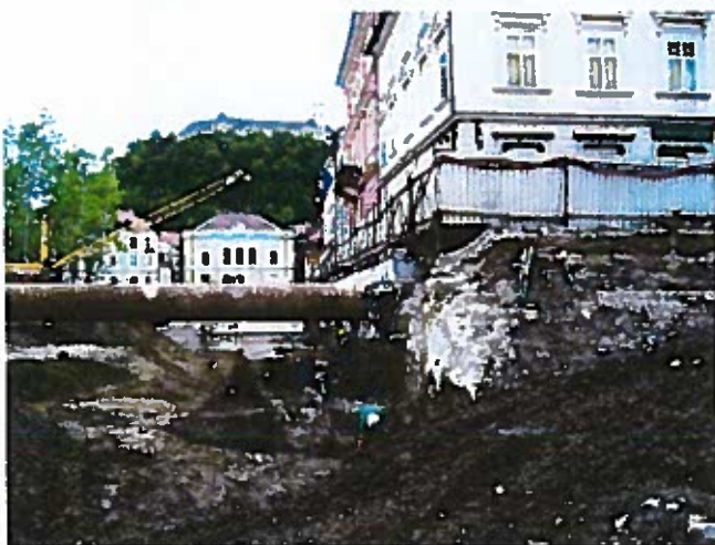
Slika 1 Izkop ob severni steni ocenjene globine preko 3m je varovan z razpirano AB diafragma
