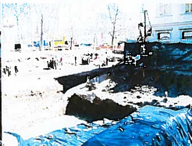
Slika 2 Ob zahodni steni je izkop deloma že izveden, poteka pa še izvedba podbetoniranja ali varovanja izkopa ob zahodni steni z Jet Grouting piloti
