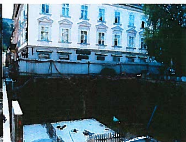
Slika 4 Ob zahodni steni objekta je izkop izveden vertikalno, kar omogoča izvedeno varovanje
