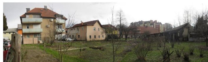
7: Gorkičeva ulica, pogled proti jugu, pogled na obravnavano območje
