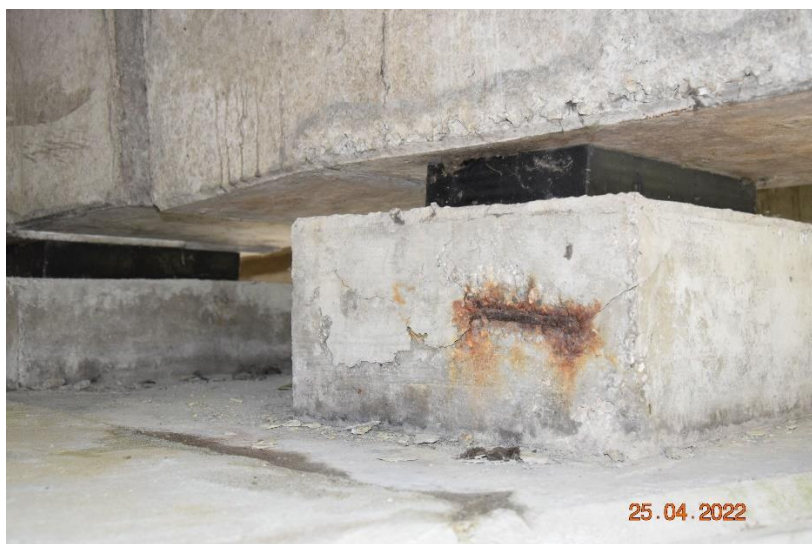
Pogled na elastomerna ležišča in ležiščne bloke
