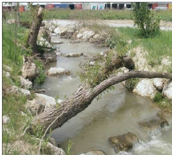
Slika 1: Sonaravno utrjena brežina s kamni in vrbovimi potaknjenci (vir: Handbuch Wasserbau - Naturgemäße Bauweisen, Heft 5: Ufer- und Böschungssicherung) in primer izvedbe izrazito neporavnanih utrjenih brežin s skalami samiciami in kamni (privzeto iz Grundlagen für einen österreichischen Leitfaden zum Bau von Fischaufstiegshilfen (FAHs). Bundesministerium für Land- und Forstwirtschaft, Umwelt und Wasserwirtschaft, Wien, 2011).
