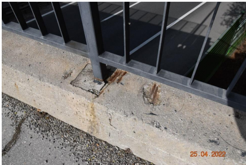
Pogled na jekleno ograjo in vpetje stebrišča v hodnik. Pri stiku med stebrički in hodnikom so vidne poškodbe v obliki deliminacije betona in korozije armature ter jeklenih stebričkov ograje.
