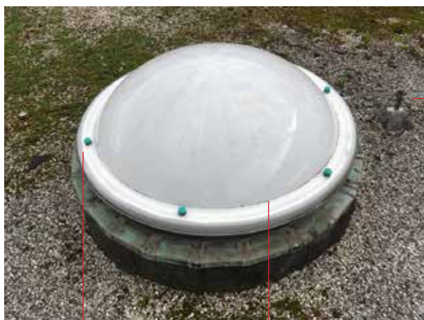
dotrajana obrobna pločevina, nova kupola
