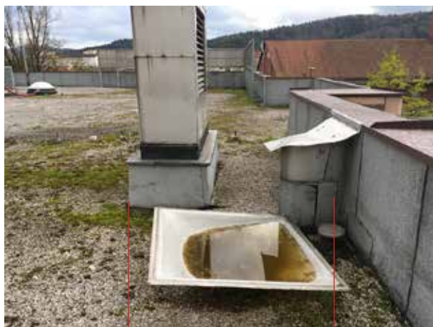
ventil za odzračevanje ekspanzijske posode - odstranitev
