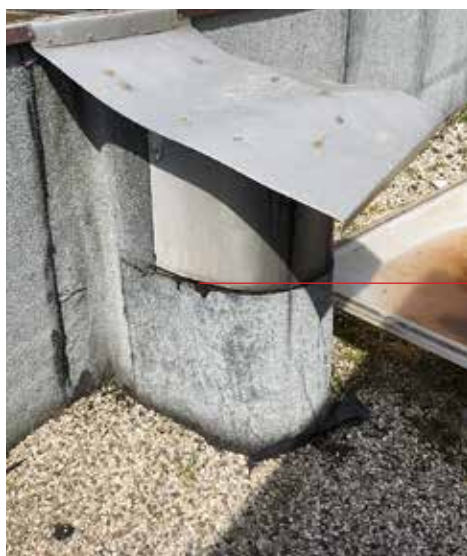
ventil za odzračevanje ekspanzijske posode - odstranitev
