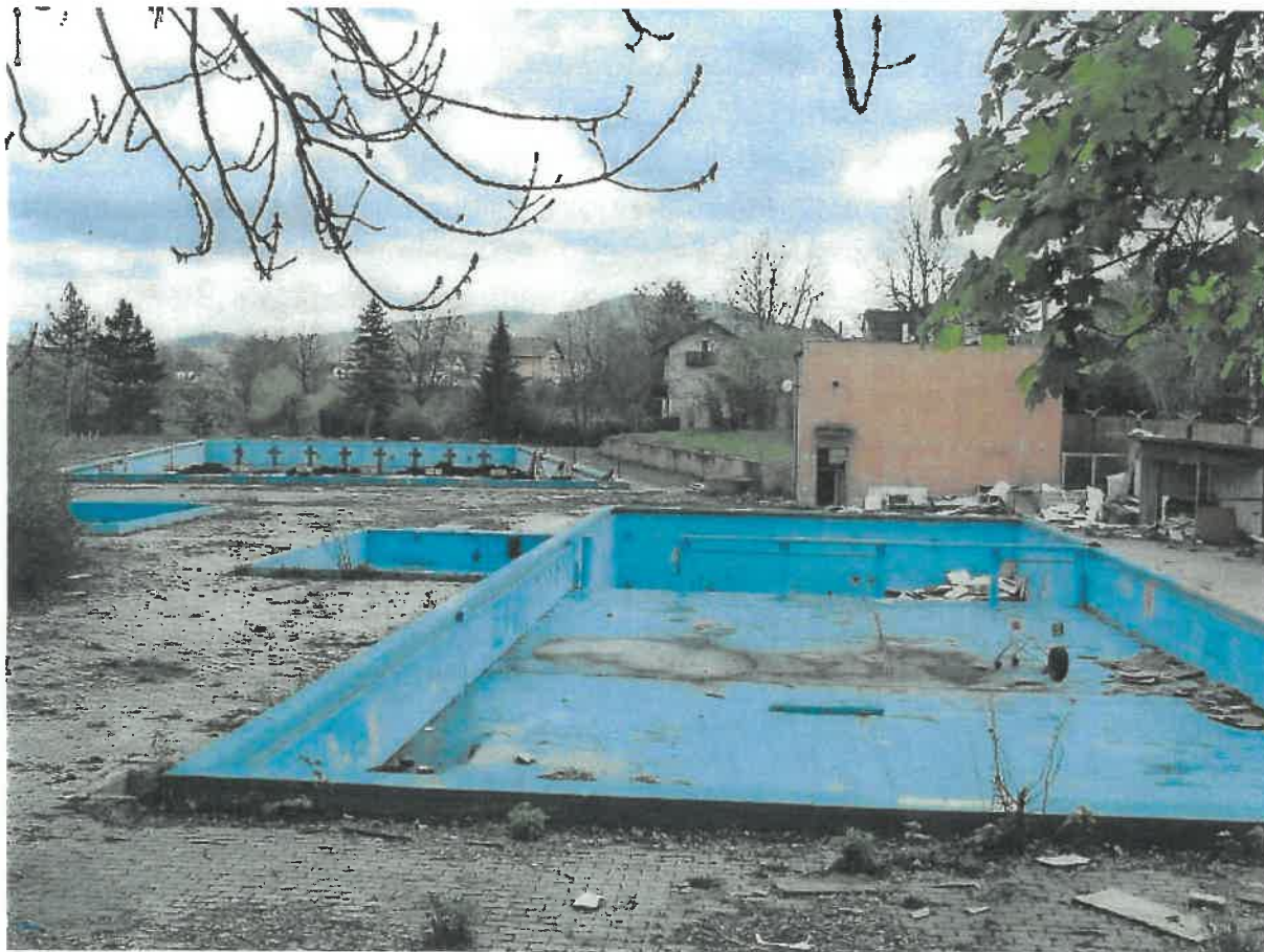
Slika 1: Pogled na trenutno stanje kopališča Vevče (Vir: Dnevnik)
