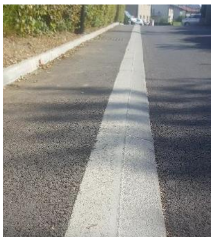
Primer vgradnje robnika v ležečem položaju, ki prikazuje dober vizualni kontrast z okolico.
