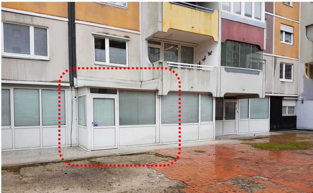
Pritlični izzidek – na mestu odstranjenih steklenih sten in strehe se bo znotraj nove steklene stene in strehe postavila nova jeklena konstrukcija
