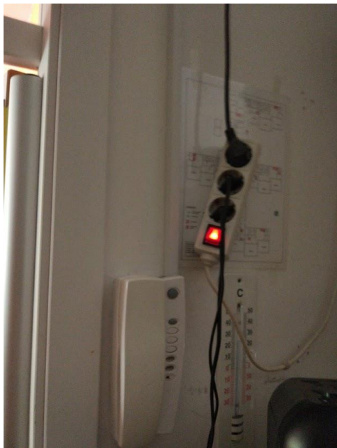
Slika 3: V igralnicah ni vtičnic oz. jih je premalo – uporabljeni so podaljški kar je nesprejemljivo!
