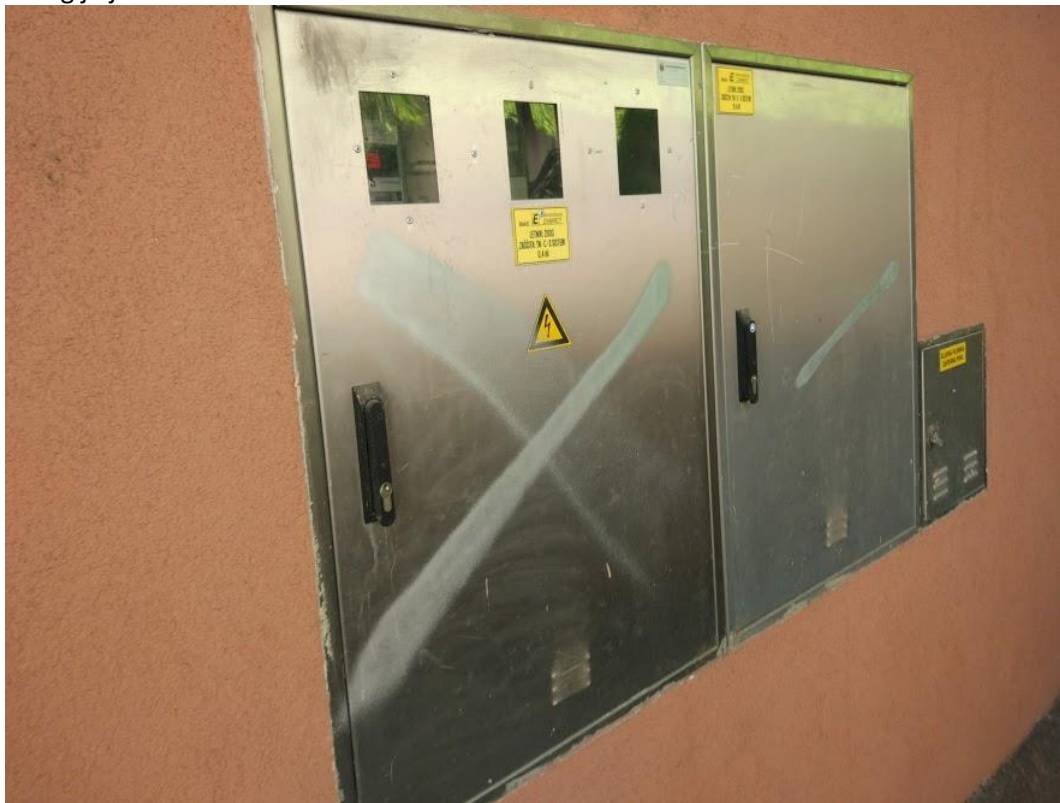
Slika 1: KPMO na fasadi objekta z glavno omarico objekta R-RAZ.
