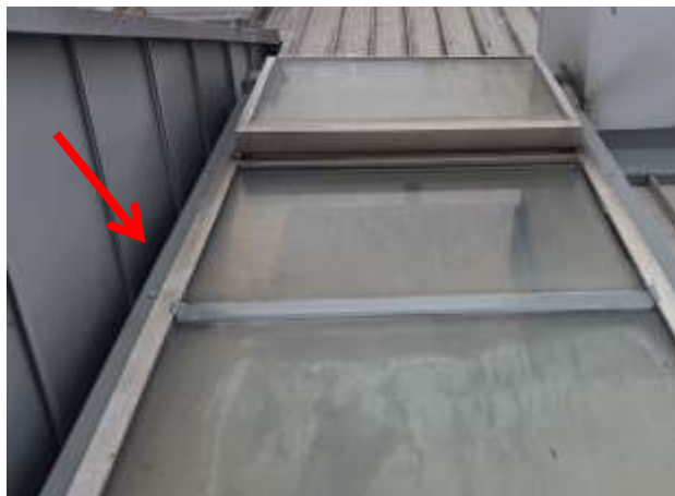
Slika 16: Koritnica med "frčado" in svetlobnikom
