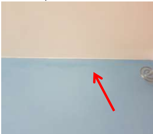
Slika 1 : Madež zamakanja na stiku obodne stene in stropa
