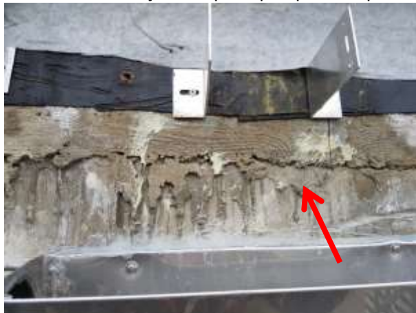
Slika 21: Pronicanje vode po in pod parno zaporo
