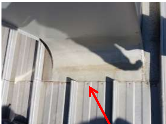
Slika 11: Stik strehe in obrobe dimnika
