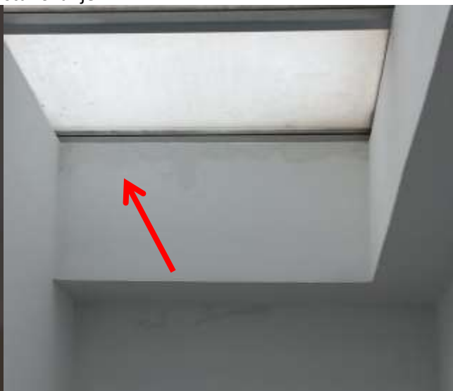
Slika 4: Madež zamakanja svetlobnika, ki meji na stanovanje
