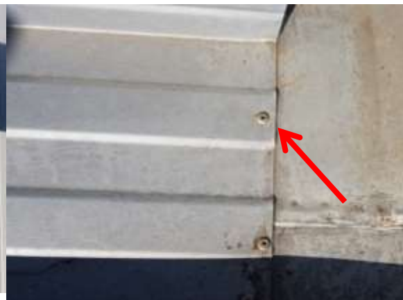
Slika 12: Kovice na stiku strehe in obrobe
