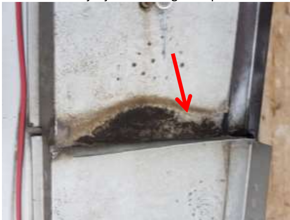
Slika 19 : Zastajanje vode za zgibom pločevine
