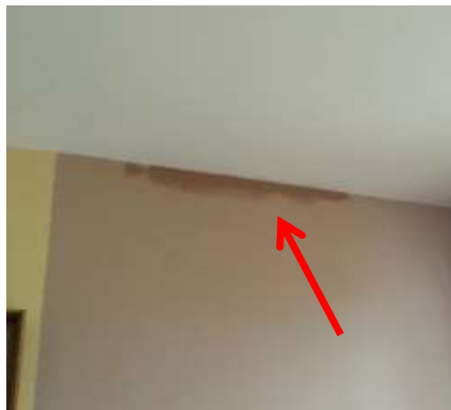
Slika 10: Madež zamakanja na stiku stropa in stene
