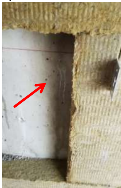
Slika 26 : Stekanje vode za toplotno izolacijo
