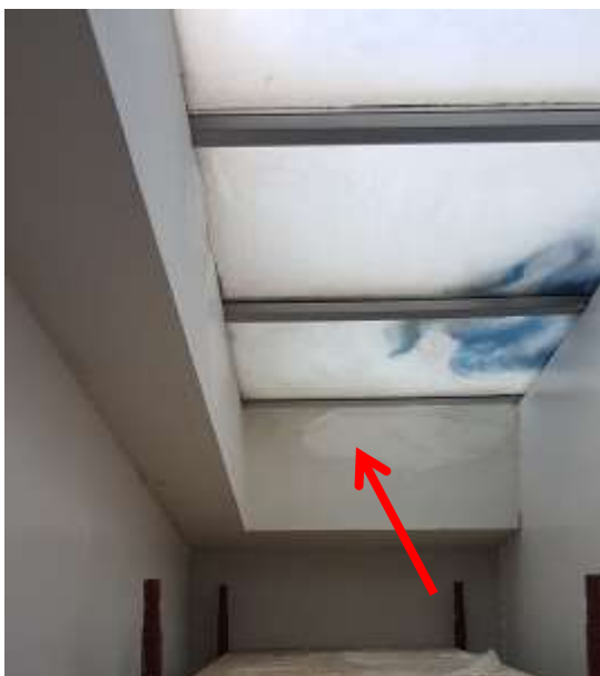
Slika 5: Madež zamakanja na špaleti svetlobnika
