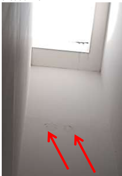
Slika 6: Madež zamakanja na jašku hodnika pod svetlobnikom
