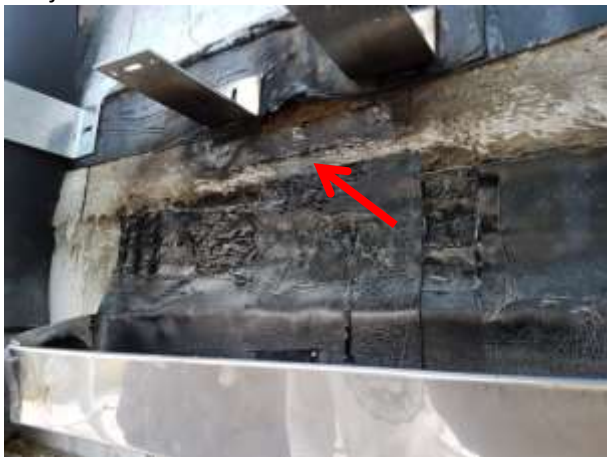
Slika 22: Prevzdignjena parna zapora, kjer se izceja voda
