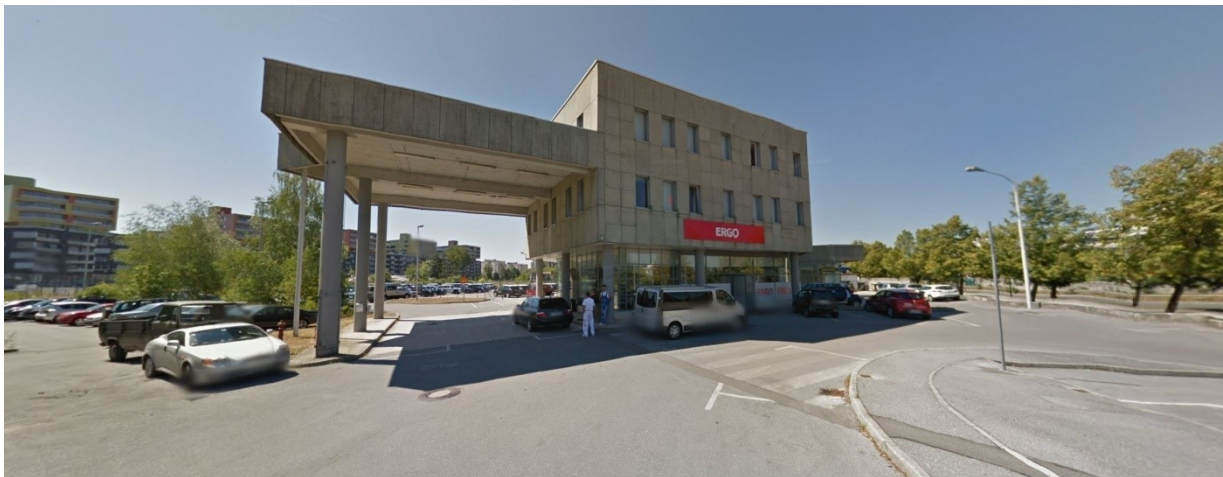
Slika 25: Pogled s severne obvozne ceste proti stavbi B (vir: Google map)
