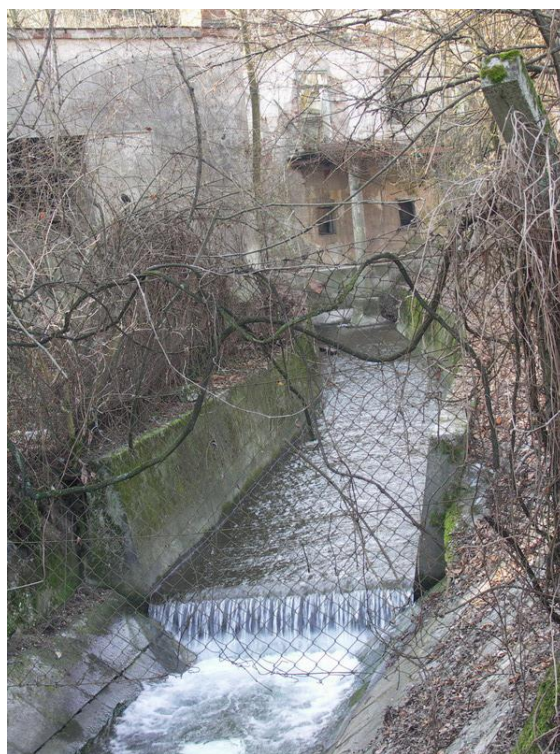
foto 2,3: prehod struge iz pravokotnega na trapezni profil (med PR 77 in 78).
