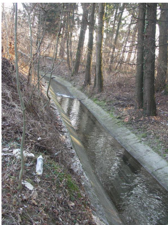
foto 2,3: prehod struge iz pravokotnega na trapezni profil (med PR 77 in 78).
