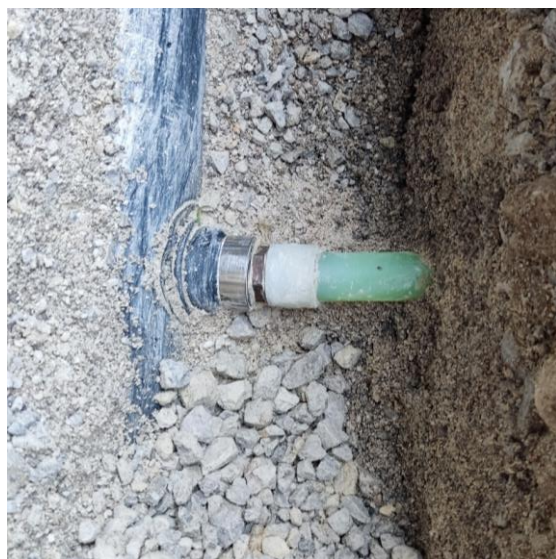
Obstoječa izvedba spoja med kolektorjem in stransko cevjo
