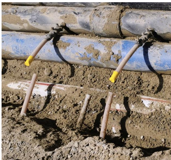
Prekinitev in zaščita obstoječih cevi
