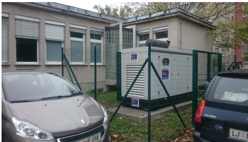
Slika 6: Agregat na betonskem podstavku, zaščiten z mrežno ograjo na Z strani objekta
