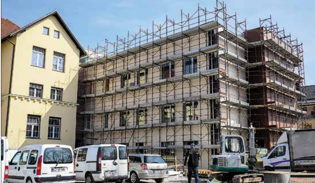
Na OŠ Vide Pregarc poteka gradnja prizidka in zaklonišča, protipotresna in energetska sanacija, gradnja športnega igrišča in ograje, gradnja bo končana septembra 2015.
