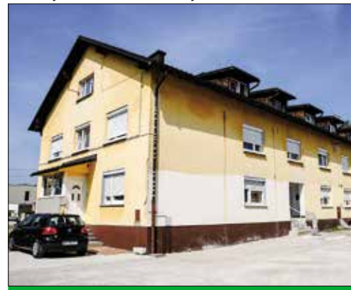
V Črnučah sta v stavbi z bivalnimi enotami na Cesti 24. junija 32 prenovljena 1. nadstropje in komunalna infrastruktura.
