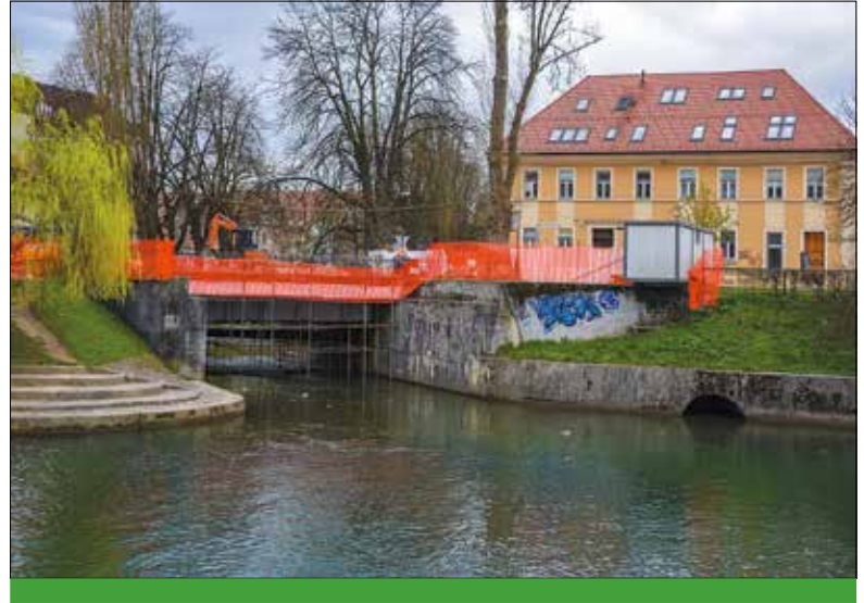
Prenavljanje mostu čez Gradaščico.
