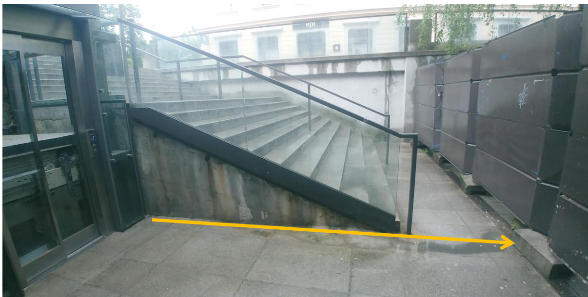
Zatekanje vode iz vmesnih plasti pod stopniščem, siga
