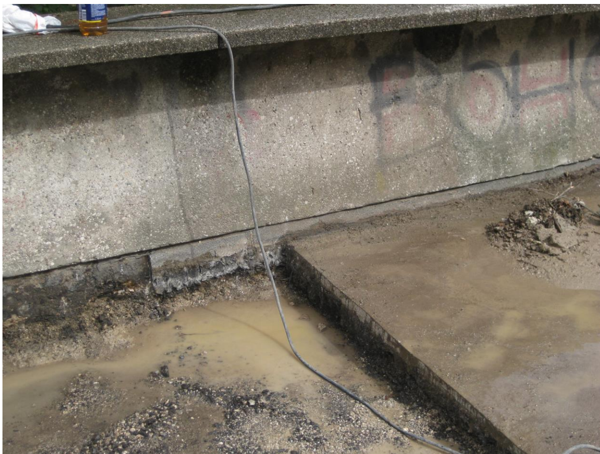
Neustrezno rešena hidroizolacija in odtok vode na nivoju hidroizolacije
