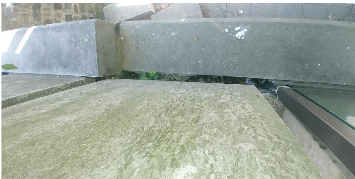
Neustrezno zaključeni stiki ograjnih elementov z okoliškim tlakom skozi katere zateka voda v konstrukcijo
