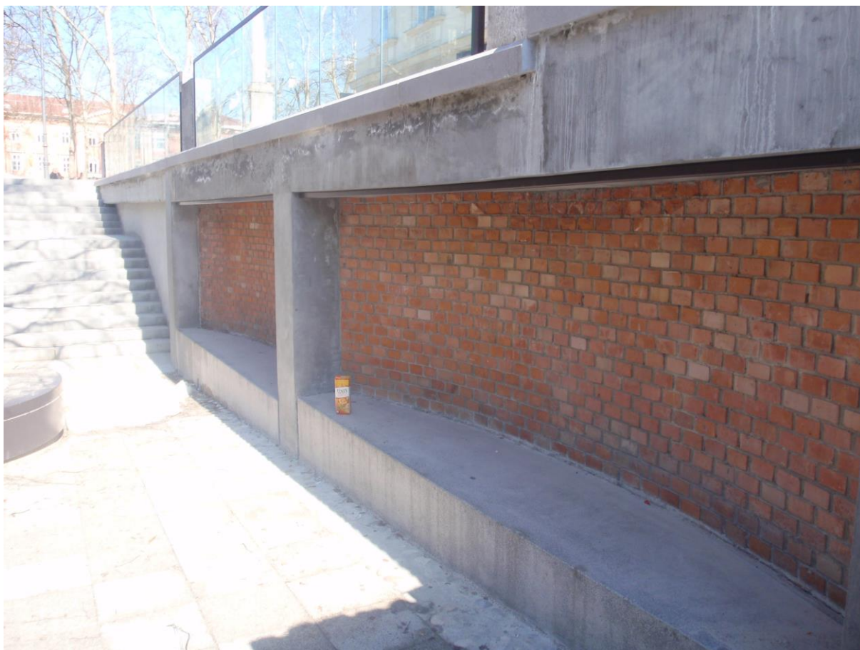
Zatekanje vode po obodnih opornih zidovih atrija
