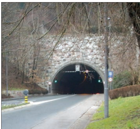
slika 1: Predor pod Gradom – vhod s Karlovške ceste
