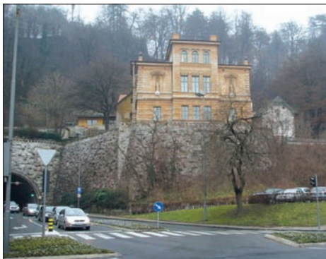
slika 2: Nad vhodom v predor s Karlovške ceste stoji Samassova vila.
