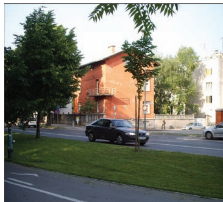
Stavba Izpitnega centra na Roški cesti
