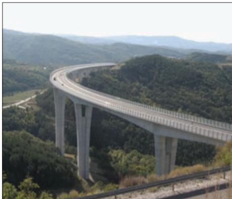
Viadukt Črni Kal (vir: http://sl.wikipedia.org , 17.9.2007)
