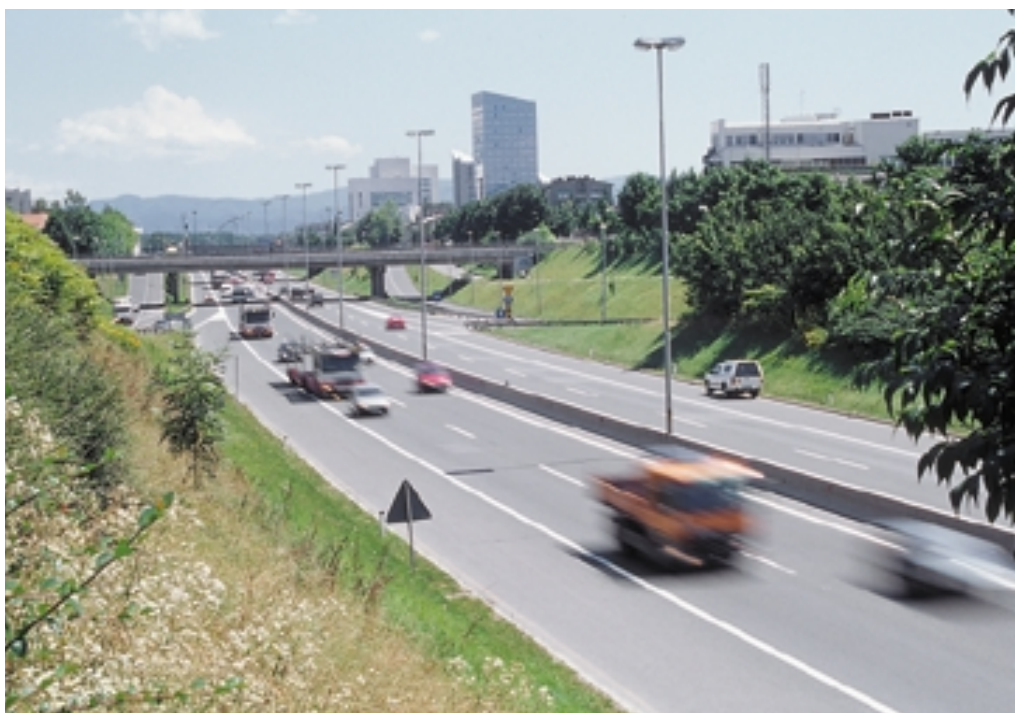
Slika 6-1: Pogled na severno ljubljansko obvoznico
