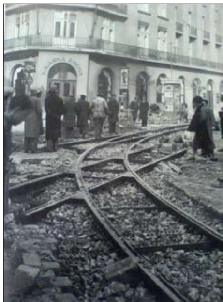
Gradnja tramvajske proge v Ljubljani (vir: www.skyscrapercity.com , 30. 12. 2007)
