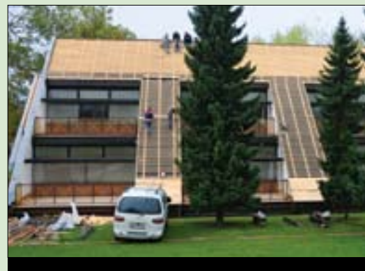
V vrtcu Ciciban, enoti Ajda, so odstranili azbestno streho in vrtec na novo prekrili.
