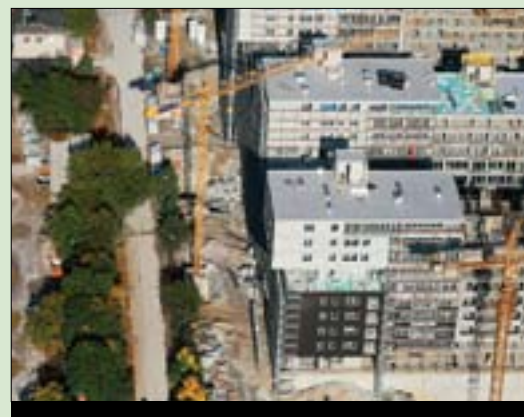
V Celovških dvorih, katerih gradnja se bliža koncu, bo Javni stanovanjski sklad MOL kupil 419 neprofitnih stanovanj.
