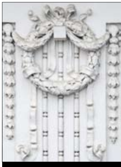
Po replikah zahtevnega fasadnega okrasja so bili izdelani mikroarmirani betonski ulitki in nameščeni na pročelje.
