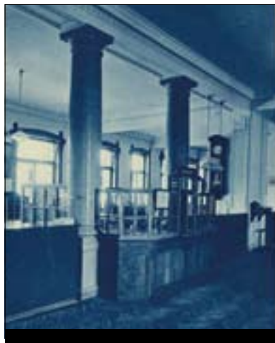
Fotografija notranjosti stavbe ob naznanilu o preselitvi v Slovencu 22. aprila 1904.
