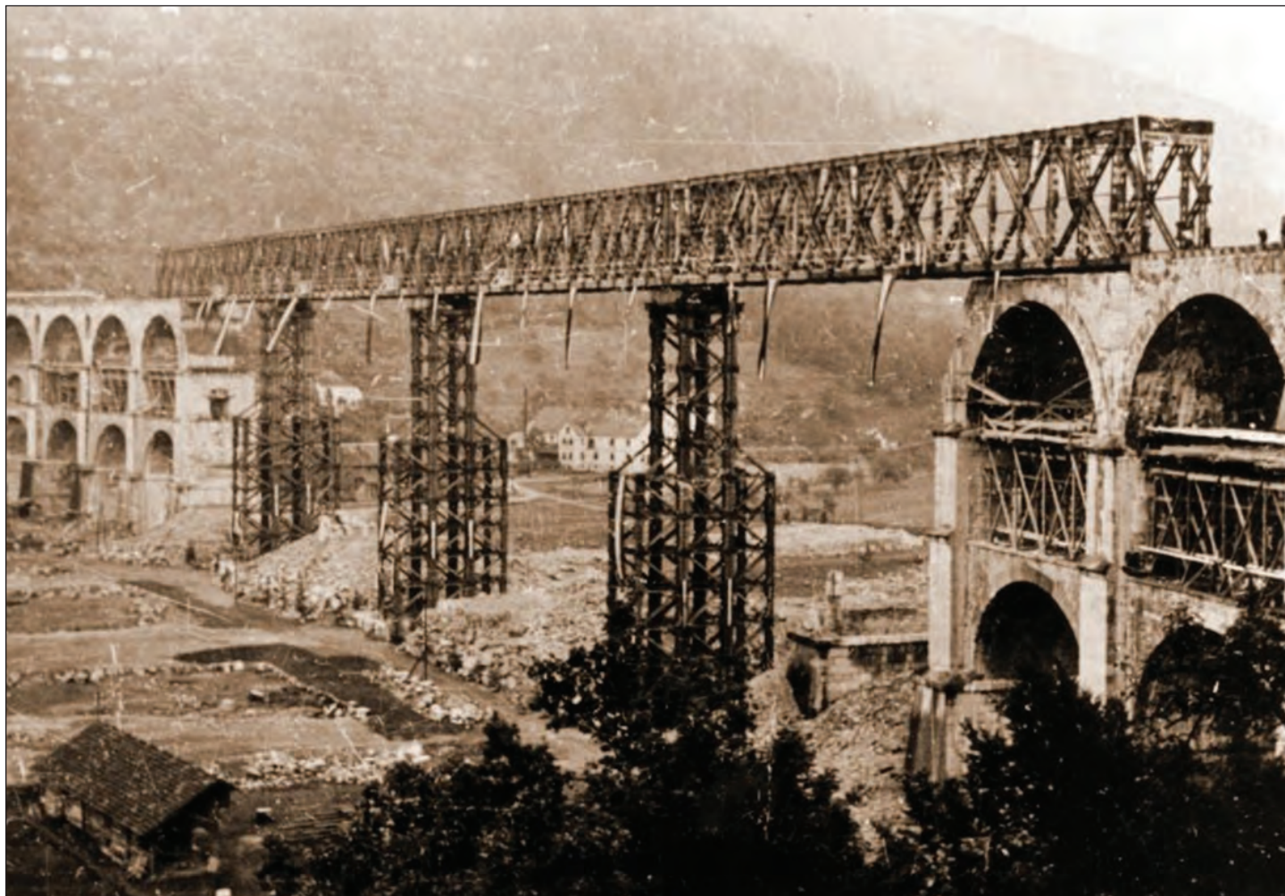
Borovniški viadukt z jekleno konstrukcijo, kot so ga leta 1941 obnovili Italijani (vir fotografije: http://www.javor.ped.uni-lj.si , 30.6.2011)
