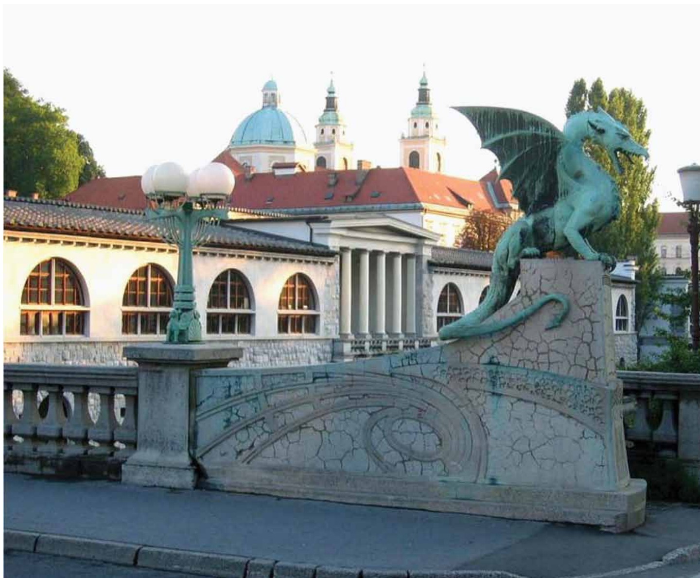
Detajl z Zmajskega mostu (vir: http://www.google.si , 30. 6. 2012)
