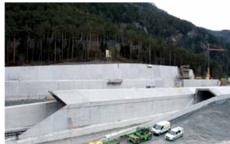
Vhod v predor na severnem portalu
