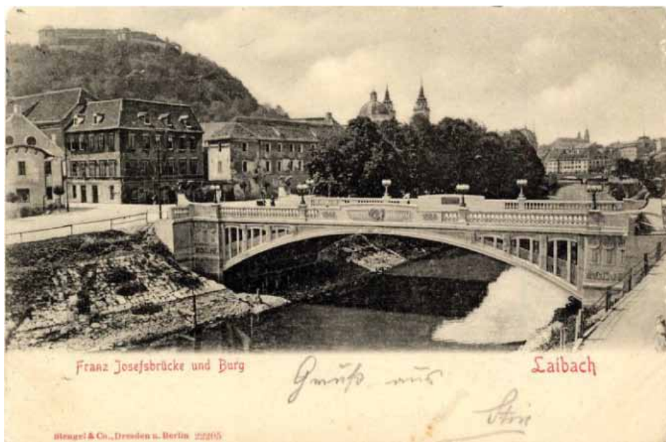
Namesto lesenega Mesarskega mostu je bil leta 1901 zgrajen Jubilejni, danes Zmajski most. (vir: http://www.dlib.si , 30. 6. 2012)
