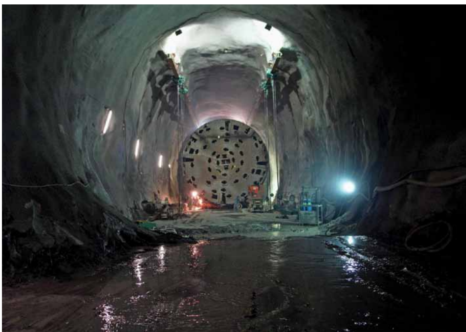
Vrtalni stroj pri preboju predora
