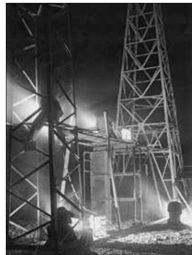
Varjenje daljnovodov s Furlanovimi varilnimi aparati.
