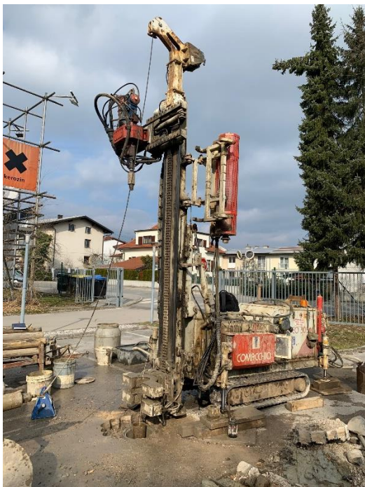
Slika 1: Ponikalni test vrtine V-1/22
