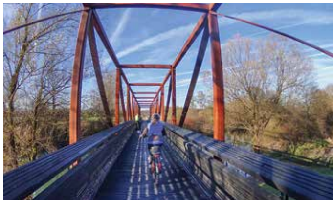
Vodovodni most povezuje ČS Vič in ČS Rudnik
