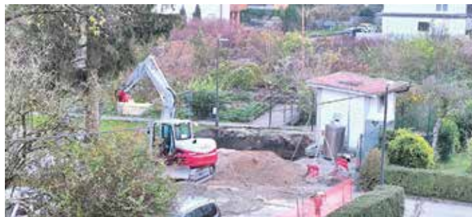
Gradnja novega komunalnega črpaljšča na Melikovi
