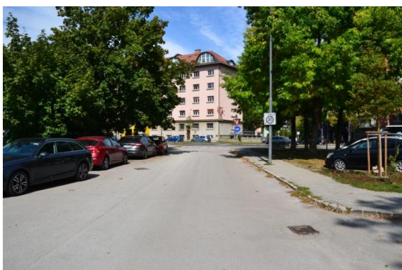
Slika 29: Gospodinjska ulica (severni del) – lokalna krajevna cesta
