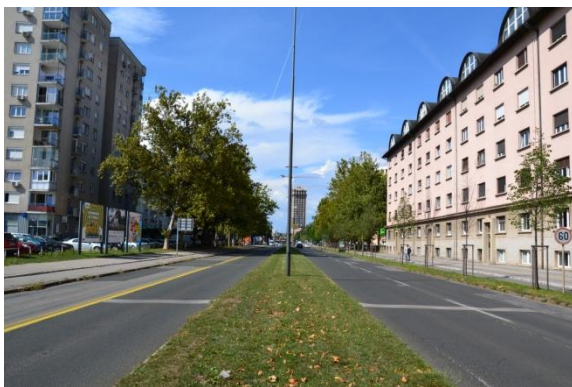
Slika 28: Celovška cesta – lokalna glavna cesta
