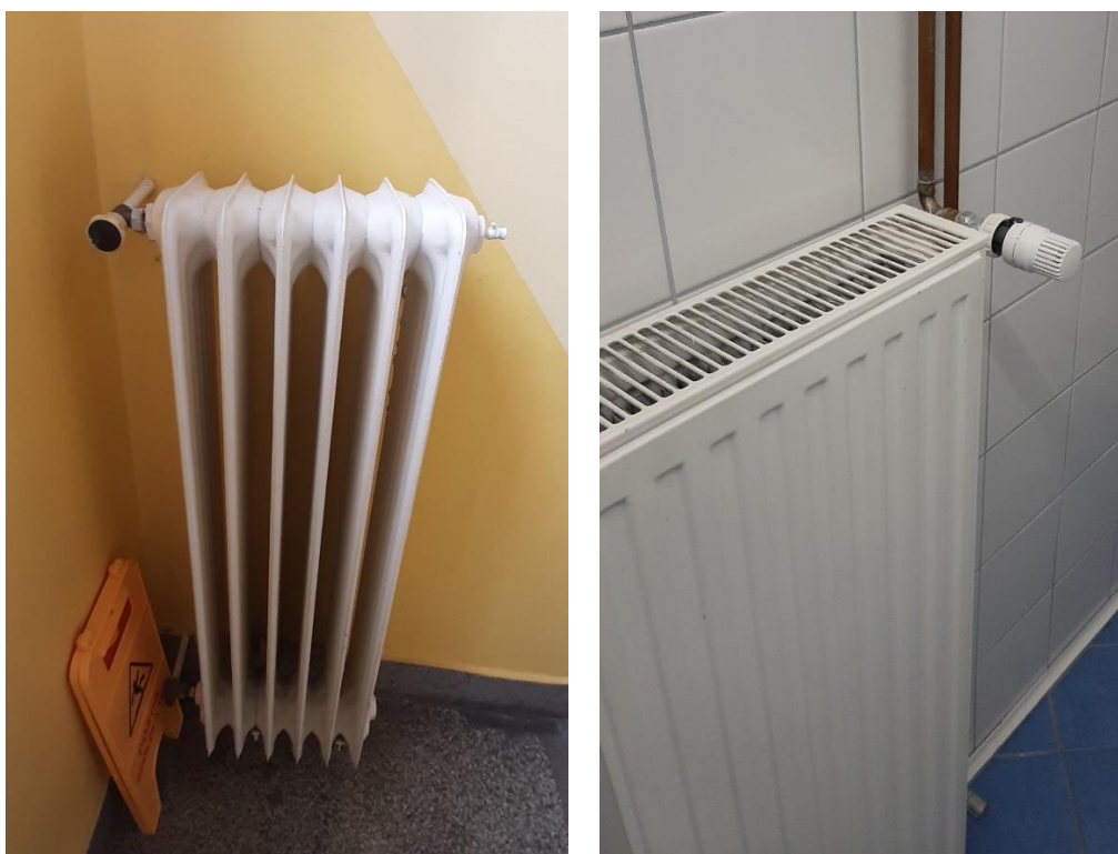
Slika 4.3: Primer rebrastega litoželeznega radiatorja (levo) in ploščnega radiatorja (desno)
