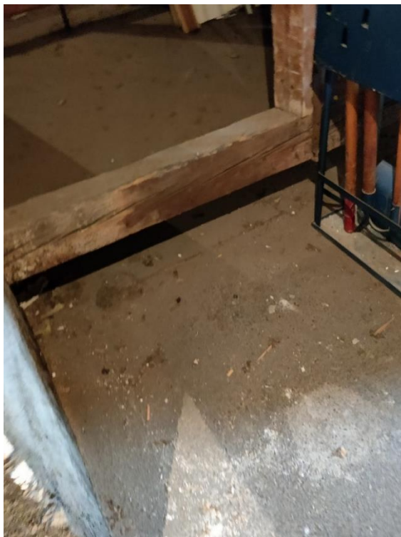
Slika 5.3: Stropna konstrukcija proti neogrevanemu podstrešju (zgornja stran)
