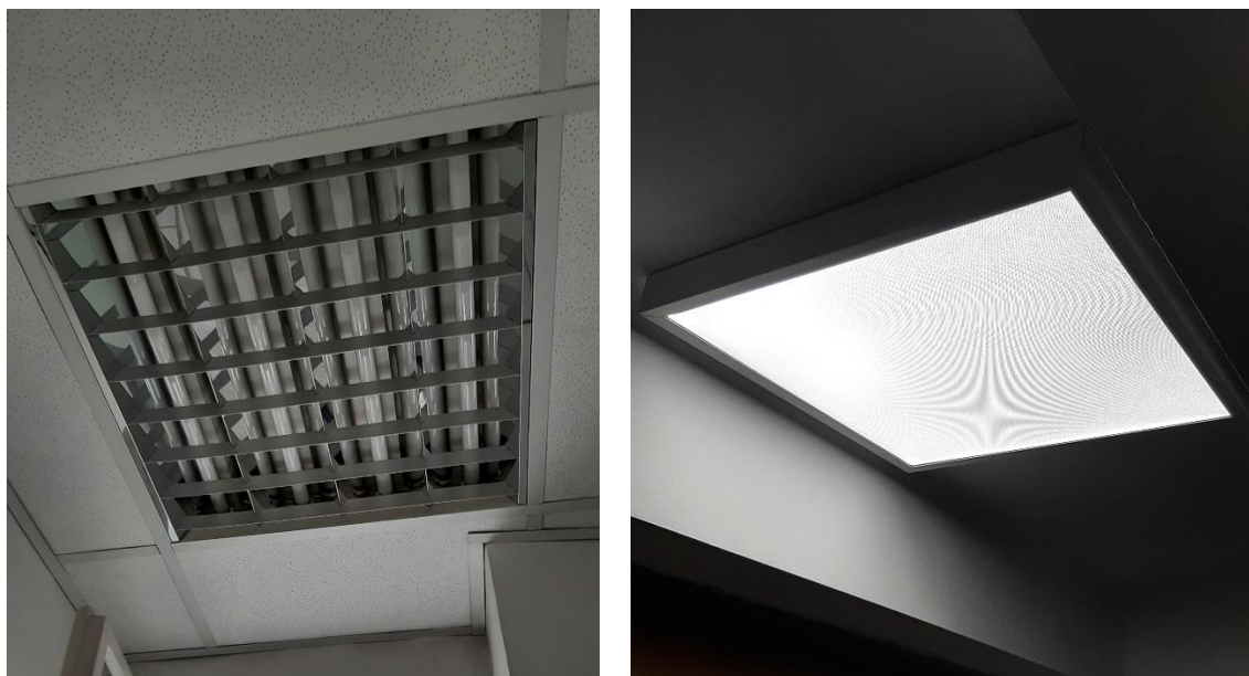
Slika 4.6: Fluorescentna svetilka T8 (levo) in novejša LED svetilka (desno)
