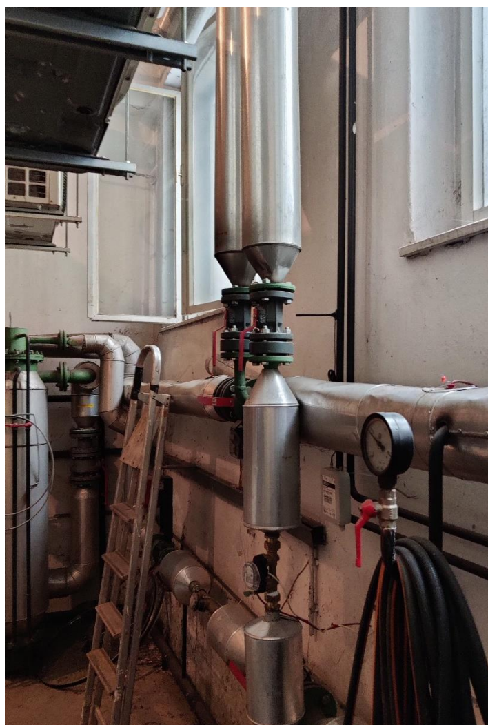
Slika 4.4: Odjemno mesto toplotne energije za toplo sanitarno vodo
