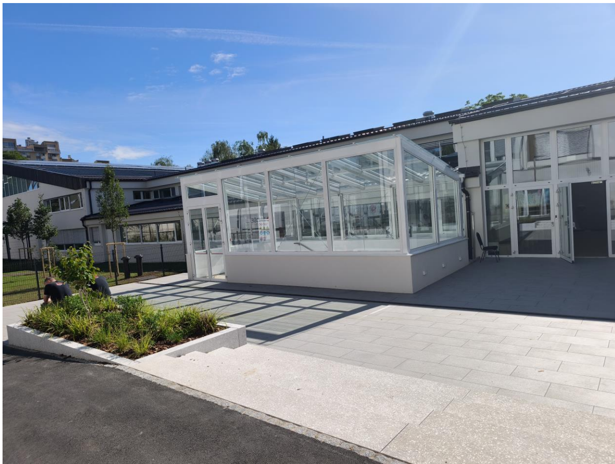
po obnovi junij 2026 – prenovljen vhod in ploščad pred vhodom
