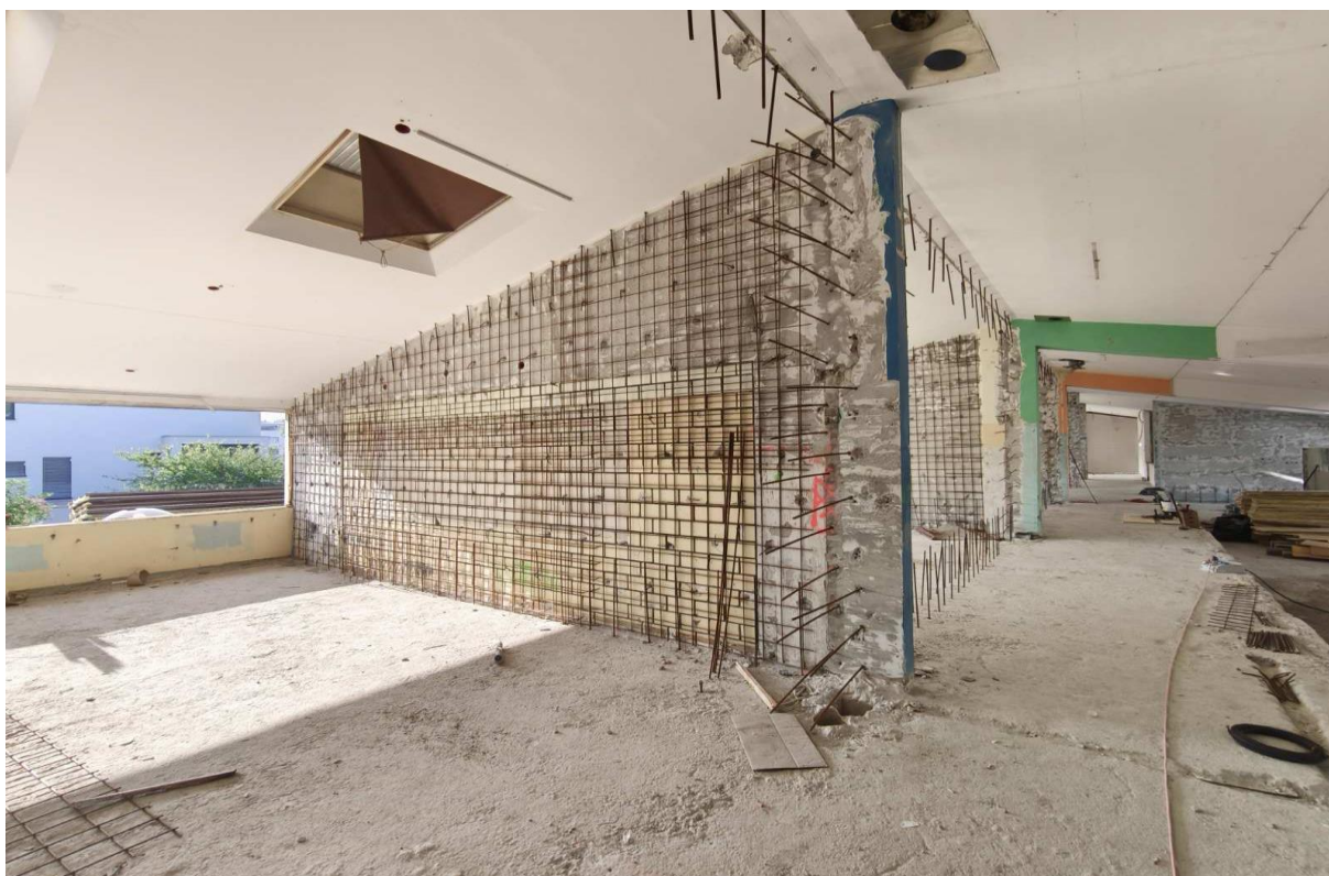
Avgust 2025 – statična sanacija
